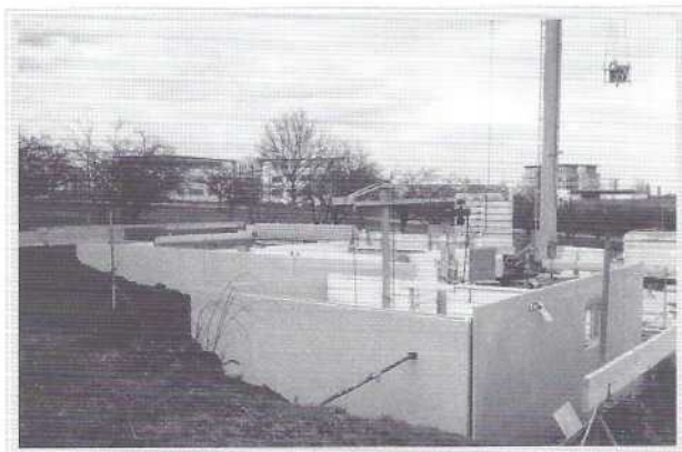
01. April 1998 "Die ersten Mauern stehen"
