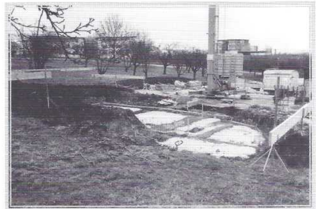
18. März 1998 „Das Fundament ist gegossen“
